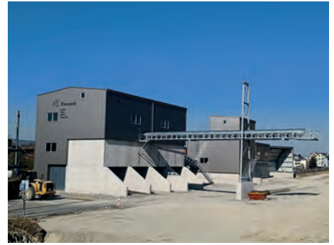
Aushubwaschanlage Kieswerk Ballwil
