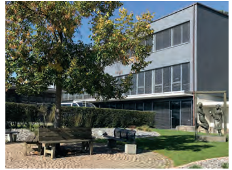
Neuer Anbau der Schulanlage
